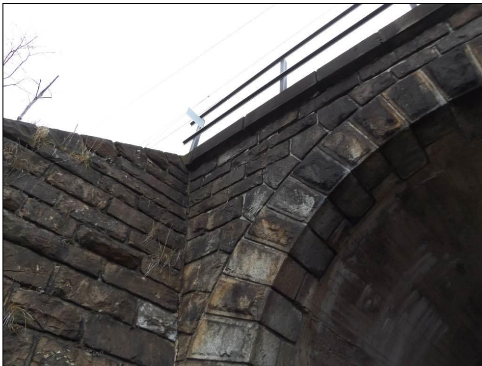
Obr. č. 13 - pohled na betonové „prefabrikáty“ vybrané římsy objektu
